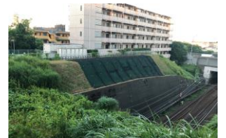
法面補強による土砂災害対策
