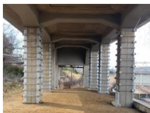
対策後（高架橋柱）
