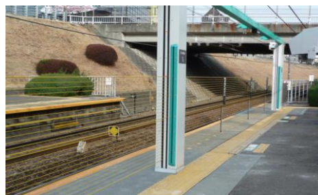
つきみ野駅 昇降ロープ式 ホームドア
