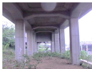
対策前（高架橋柱）
