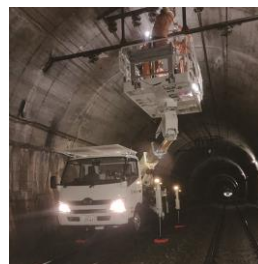
軌陸車を使用した架線設備の点検
