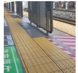
内方線付き点状ブロック
